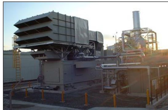
ガスタービンコージェネ設備 (設置イメージ)
